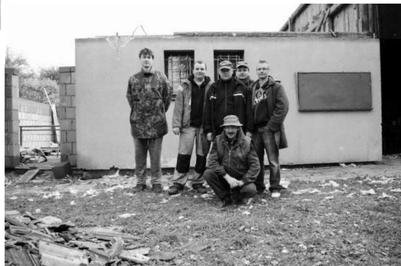
Brigáda hasičů na demolicí střechy bufetu na výletišti. Zleva Roman Odložilík, Jakub Zámorský, Aleš Hostaša, Libor Kývala, Dalibor Zámorský. Sedící je Pavel Příleský
