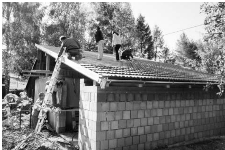
Rekonstrukce vyletiště. Pokrývání střechy pracovníky obce.
